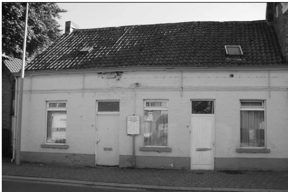
Illustratie 22. Woningen Vaartstraat 12-14, gelegen ten westen van het kasteeltje van de familie Tibbaut. De woning links werd als herberg uitgebaat door de familie Tondeleir - Meynsch. Foto André Van De Sompel, najaar 2010.
