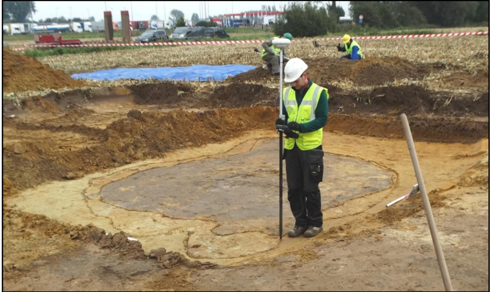
Illustratie 16. Inmeting met GPS/Total Station. Foto Ludo Van Hout.
